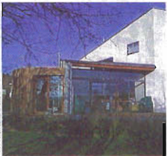
À Grand-Rechain (Herve), extension d'une habitation.
