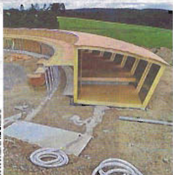
À Manderfeld (Bullange), construction d'une maison unifamiliale.
