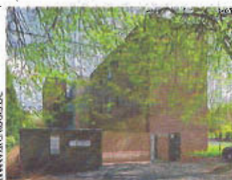
À Heusy (Verviers), extension et transformation d'une villa des années 50 (photo du haut) en logements et bureaux.
